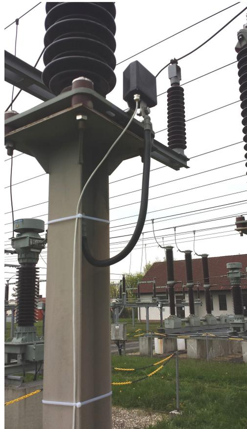
El cable de datos es resistente a la intemperie y a los rayos UV y se ha fabricado para su instalación en el exterior. No recomendamos pasar el cable por tuberías o canales para evitar daños en el cable e influencias en la transmisión de datos.
